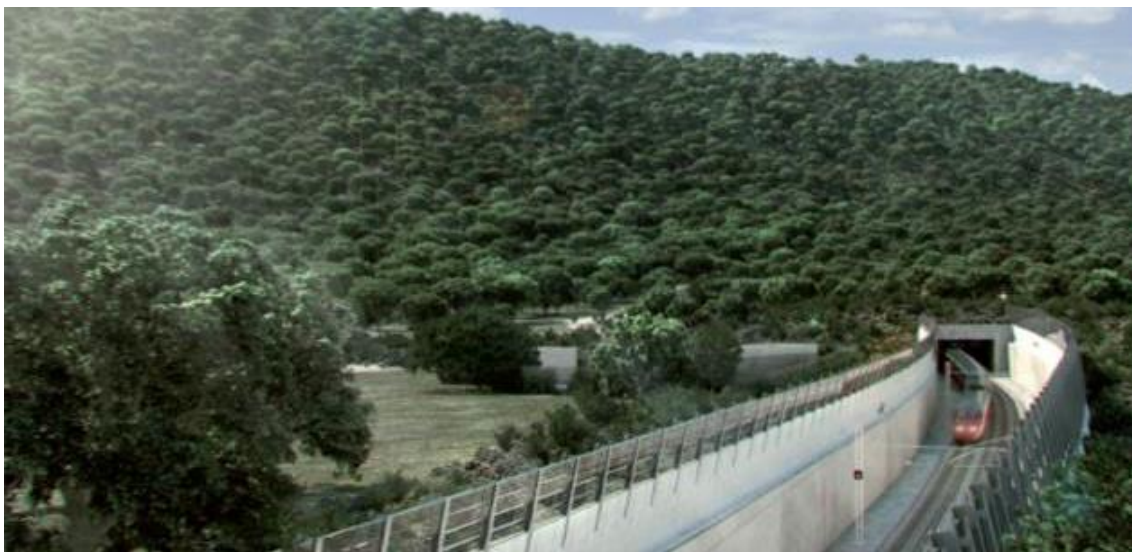
Fig. 1 – Imbocco Nord della Galleria Monte Aglio
