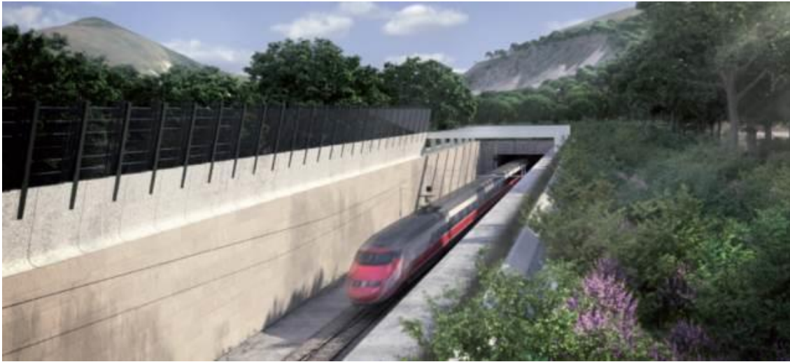
Figura 3: Imbocco Sud della Galleria Monte Aglio
